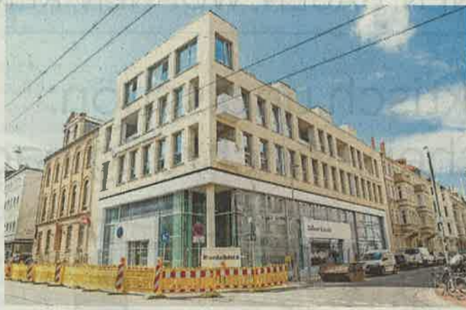
Neben dem Geburtshaus von Unternehmenschef Heinrich Jacobi: Seit 2019 wird an der Falkenstraße das „Linden Quartier“ errichtet. FOTO: KATRIN KUTTER
